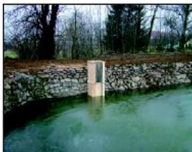
Opravená výpusť Veského rybníka v Kublově
