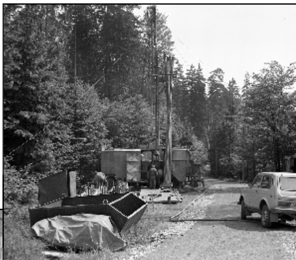
Budování výzkumné stanice v Mlynářově luhu
