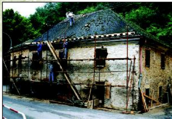
Zahájení rekonstrukce budovy Správy v Křivoklátě
