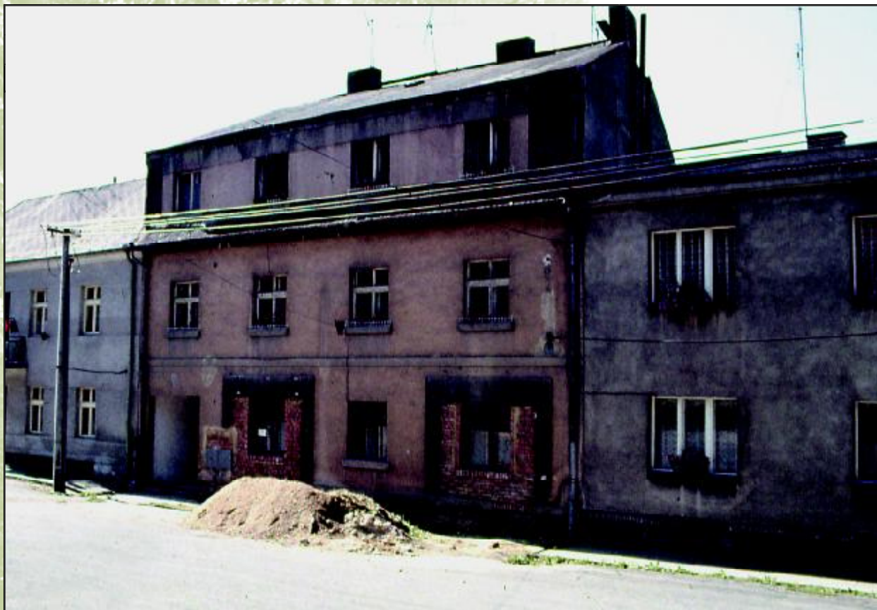
Nová budova Správy CHKO ve Zbečně před rekonstrukcí
